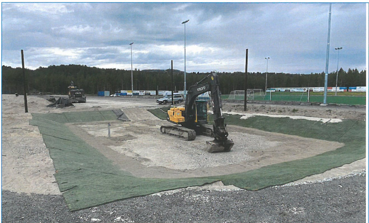
Bilder fra bygging av Sandvolleyballbanen.
