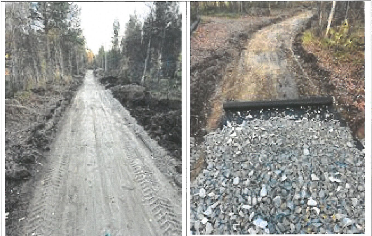
Fra grunnarbeidet med Kraftlagsløypa.
