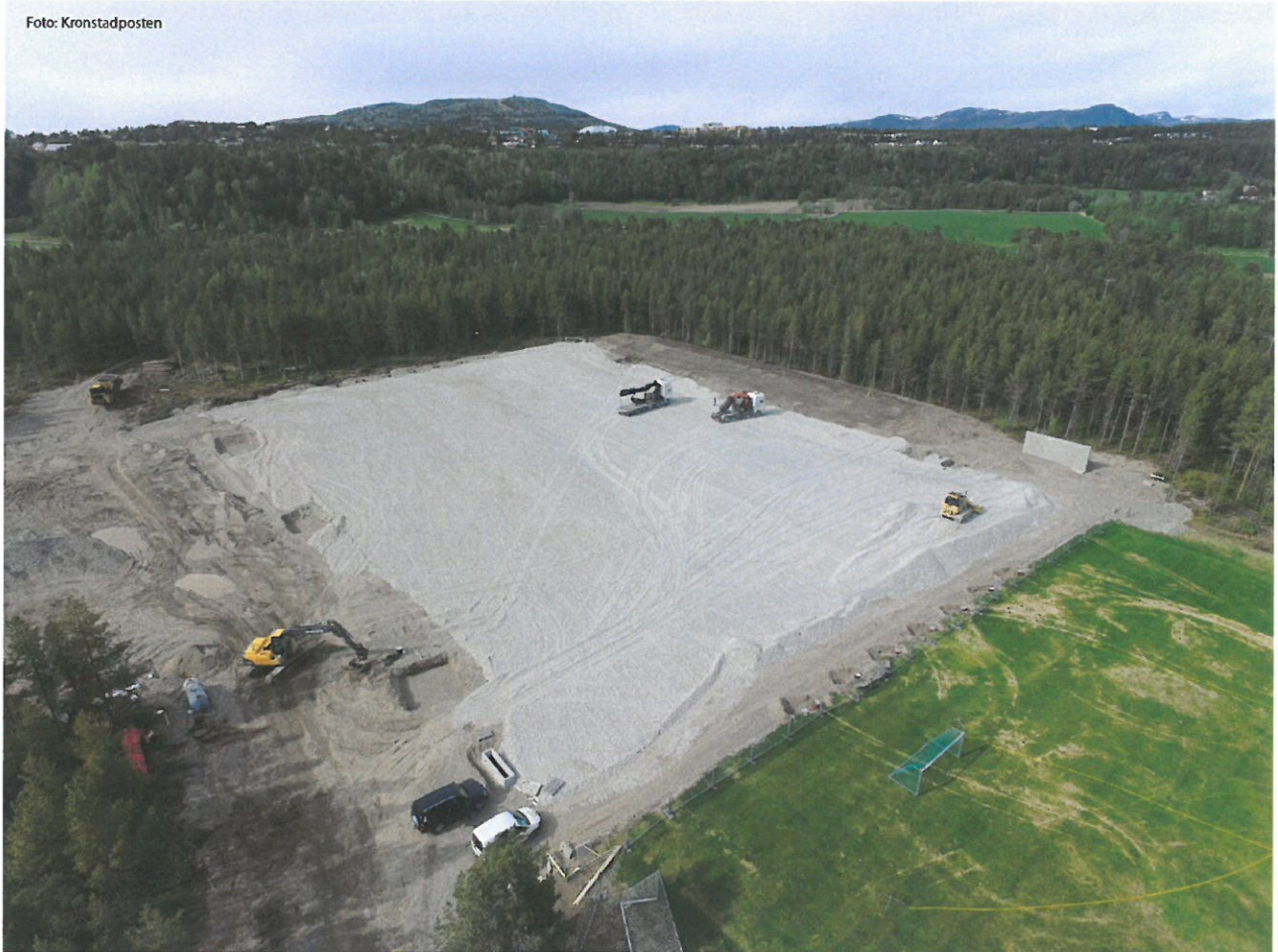
Foto tatt under bygging av Villaksbanen (Foto: Kronstadposten)
